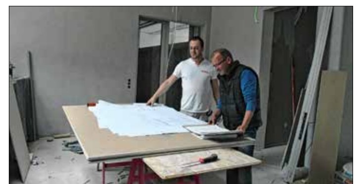
Romeo Förderer vom gleichnamigen Maler- und Gipsbetrieb studiert mit seinem Mitarbeiter die Pläne fürs Obergeschoss des Neubaus.
